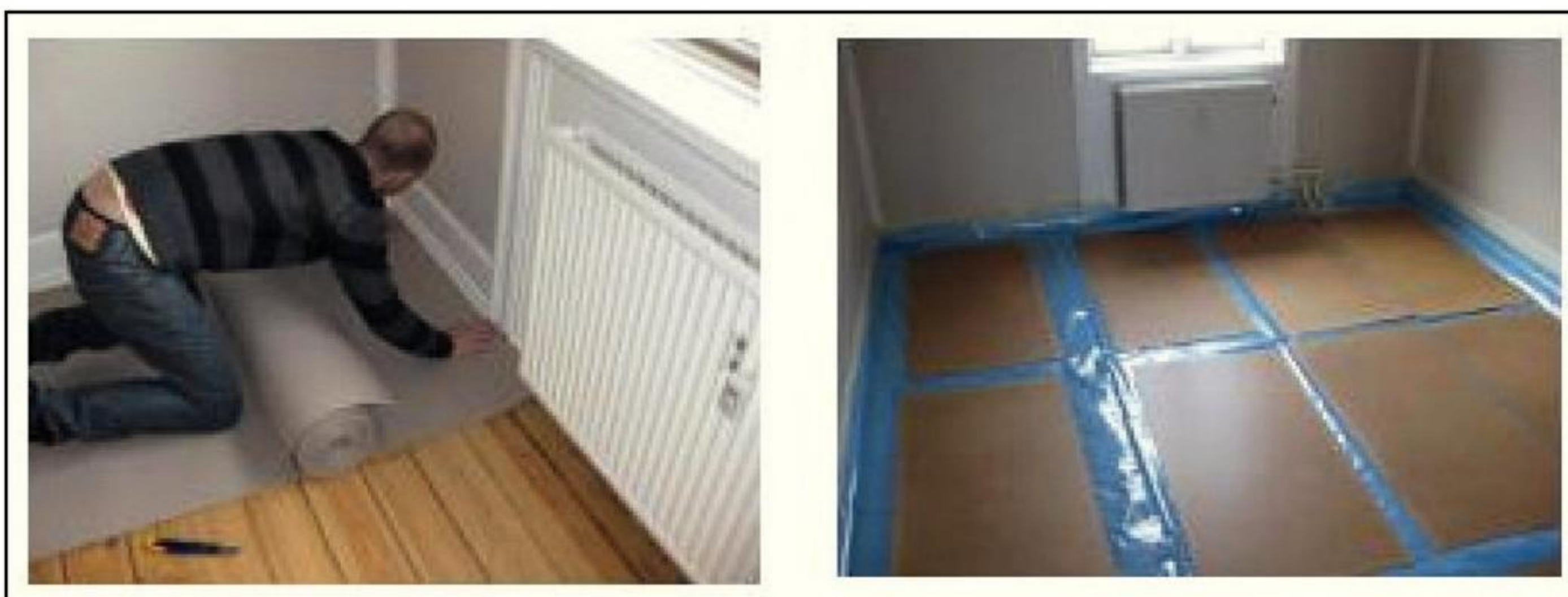
Figur 2. Tætning af eksponeringslejligheden.
